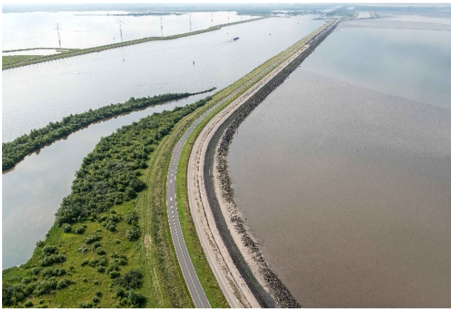
Fig. 2. Oyster Dam ( https://beeldbank.rws.nl , Rijkswaterstaat / Joop van Houdt).
